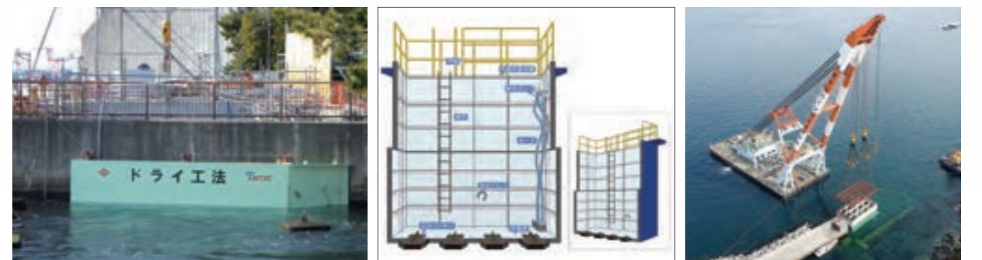
ドライ工法による橋脚補修事例
