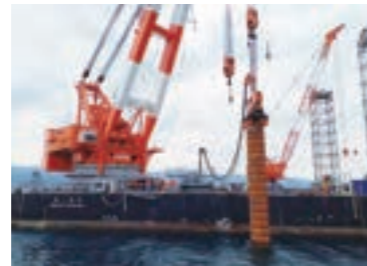
杭建て込み状況
