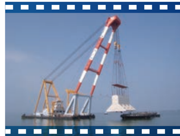
熊本港南防波堤の軟弱地盤着底式ケーソンの据付工事
