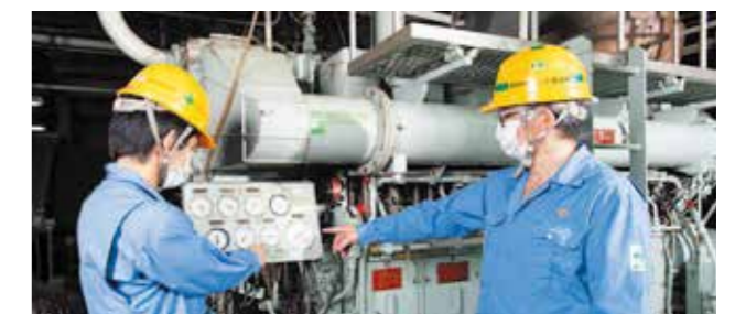
機関場作業風景
