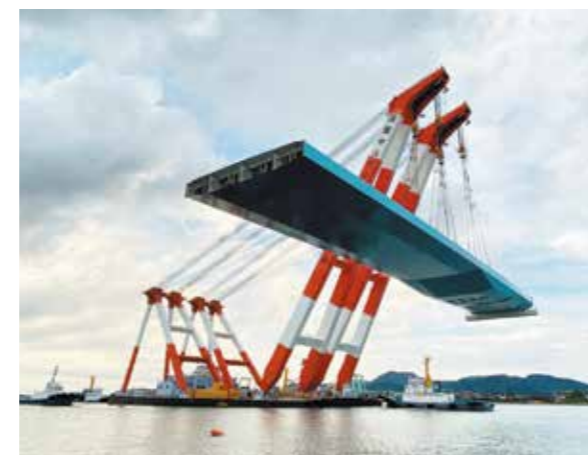
3,700t吊起重機船「武蔵」による大ブロック架設作業 徳島県新町川左岸ブロック架設
