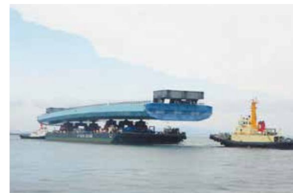
14,500t積台船「深洋」による大ブロック輸送作業 川田工業(株)多度津工場より徳島県新町川
