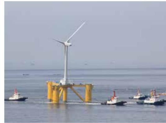
写真-1 浮体式洋上風力発電施設の曳航
