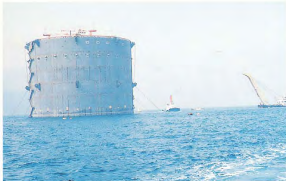
明石海峡大橋 鋼ケーソン係留作業中
