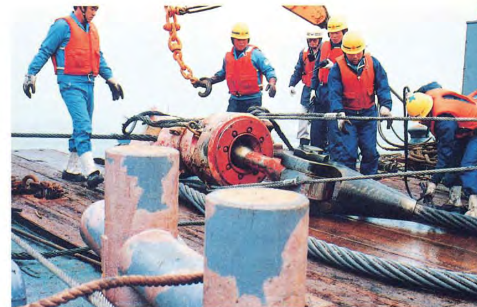
明石海峡大橋 鋼ケーソンの係留索連結作業
