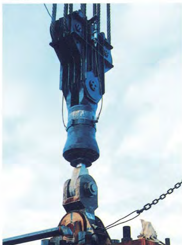
明石海峡大橋1000ton鋼製シンカーの吊上げ
