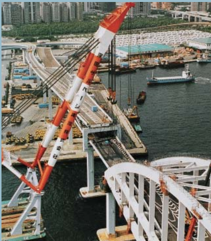
六甲アイランド橋 復旧工事
