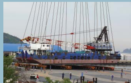
作業船吊卸・進水作業
